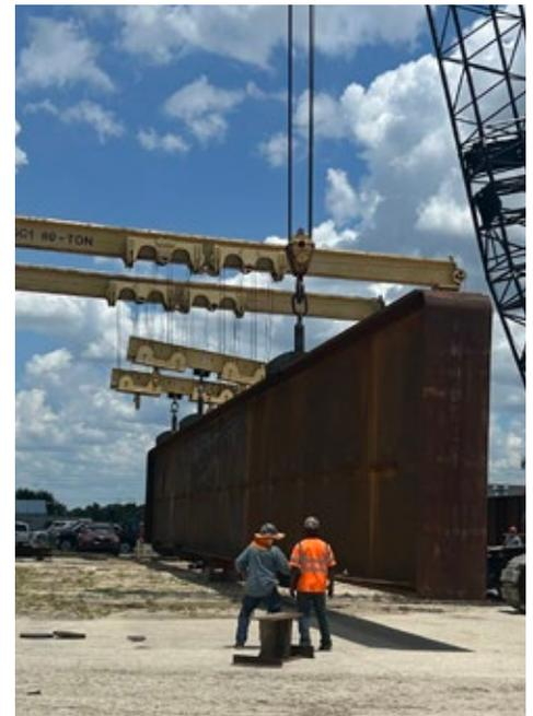
PB ha completado la fabricación y el montaje de un gran puente ferroviario en nuestras instalaciones del Puerto de Tampa Bay. Cuando esté completamente ensamblado, este puente tendrá 120 pies de largo, 40 pies de ancho y pesará 1.2 millones de libras.
