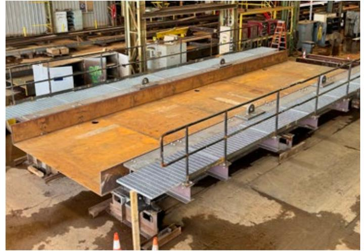
PB ha completado la fabricación, el montaje, los revestimientos y el envío de un proyecto de reemplazo de puente. El puente de 39 pies de largo, 26 pies de ancho y 200,000 libras se fabricó y ensambló en
